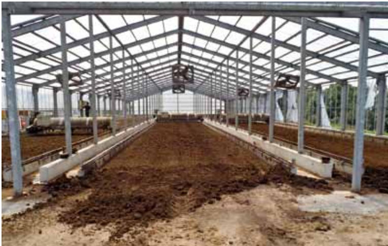
火力を使用せず自然大気を利用した全自動システム
